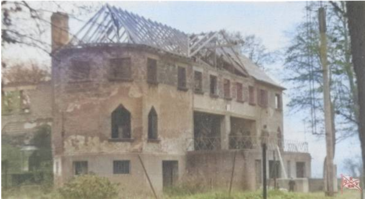
Das ORV Bootshaus im Wiederaufbau
