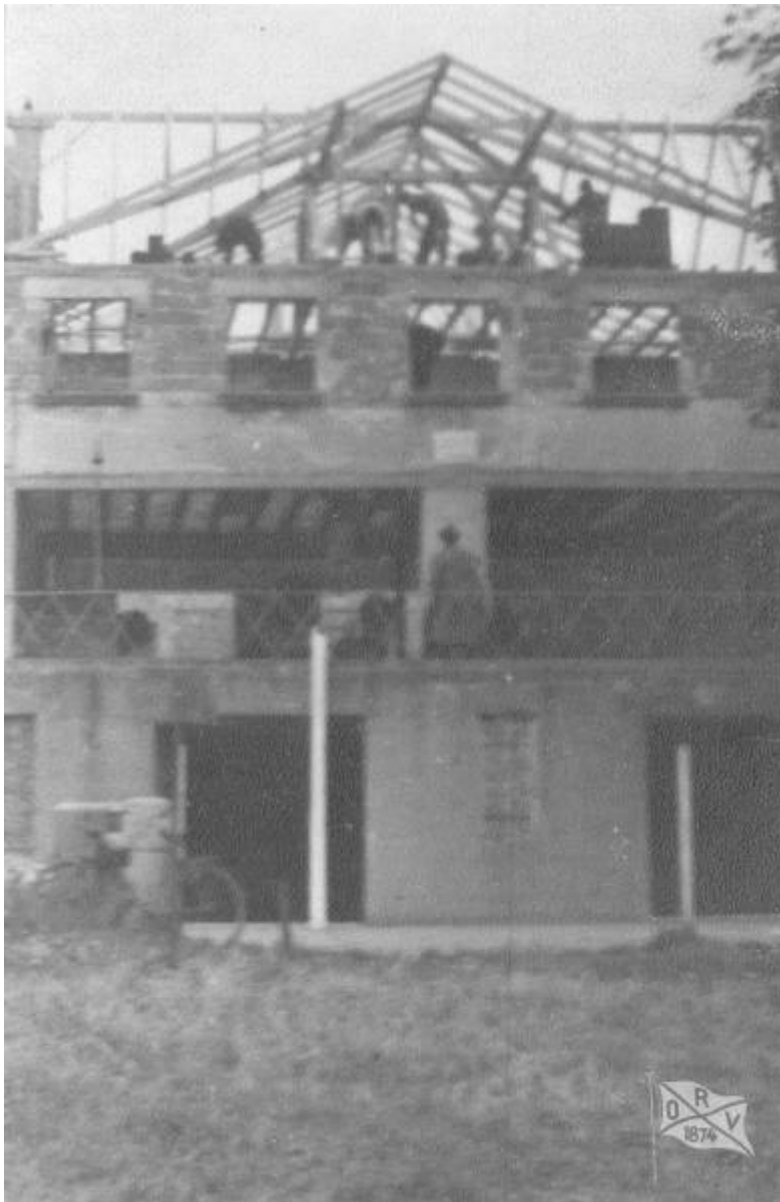
Das ORV Bootshaus im Wiederaufbau
